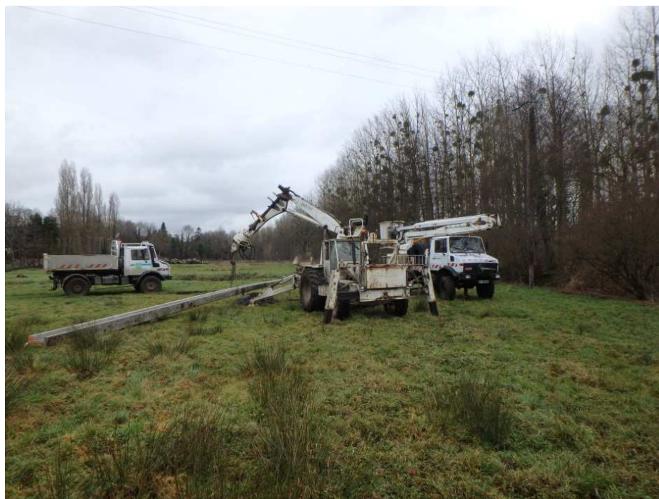
Déplacement d'un poteau EDF
